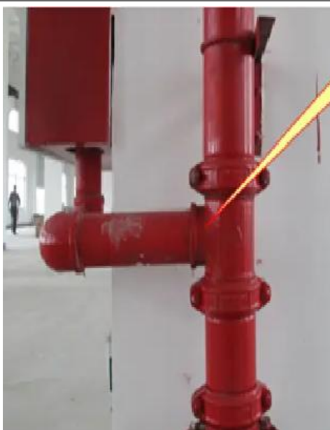
消火栓立管与水平管连接采用沟槽式三通
