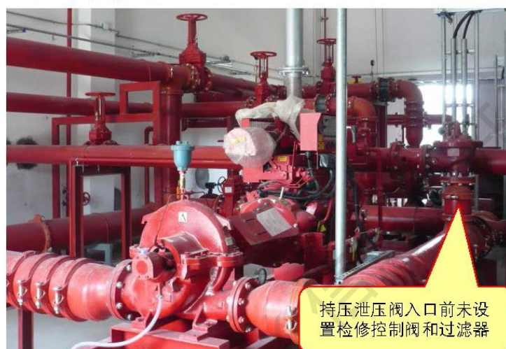
图 2.1.9 消防水泵泄压阀安装示意图
