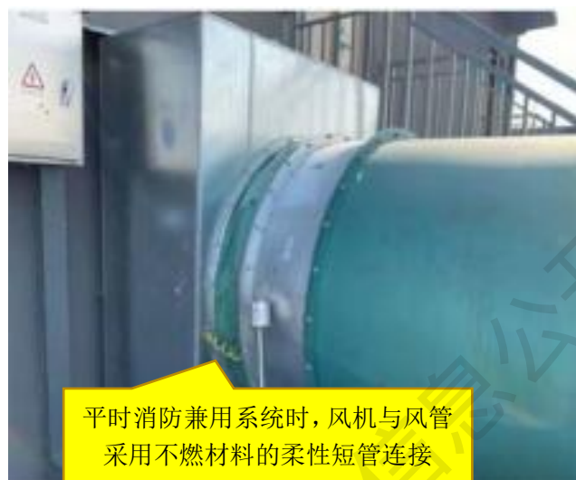
图 2.7.7 排烟与排风共用风管系统风机与风管连接示意图
