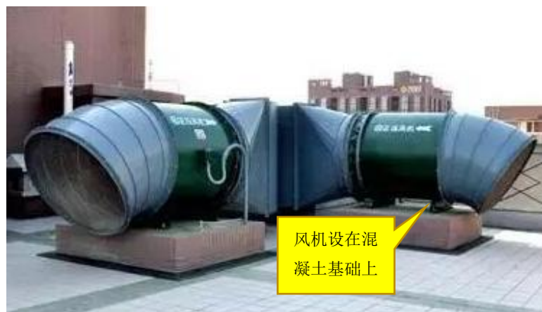
图 2.7.6-1 消防专用风机安装在混凝土基础上示意图
