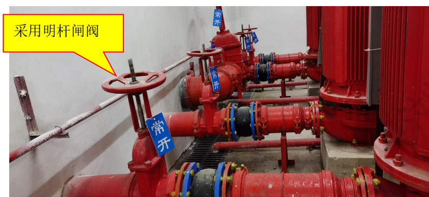
图 2.1.8 消防水泵吸水管、出水管阀门设置示意图
