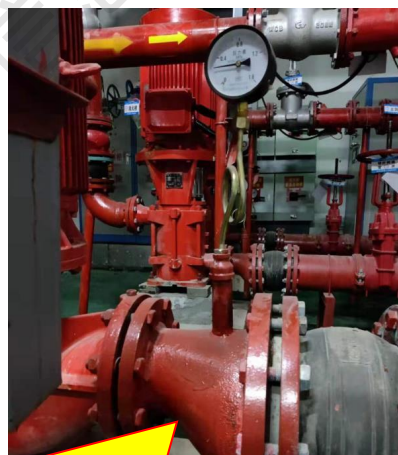
正确做法：偏心异径管安装立面图
