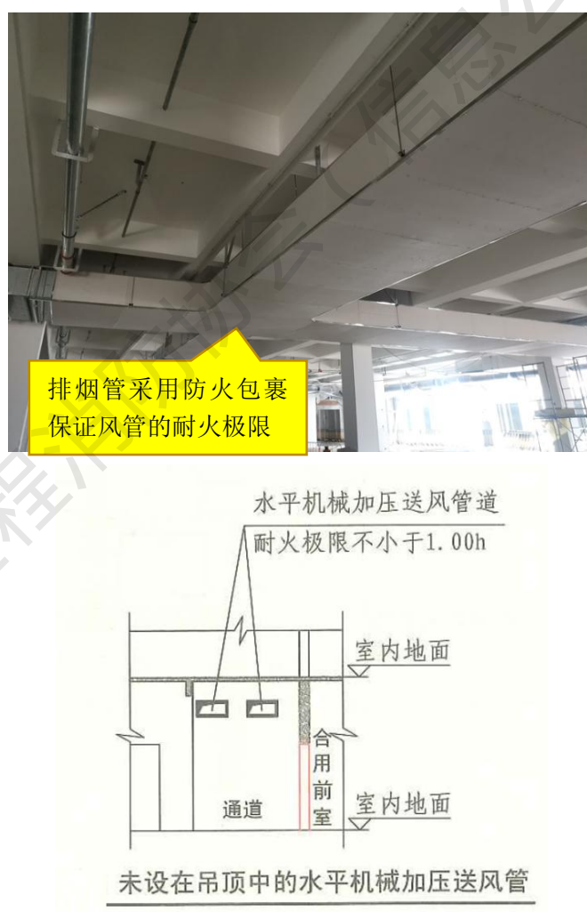
图 2.7.5-1 防排烟风管满足耐火极限要求做法参考示意图
