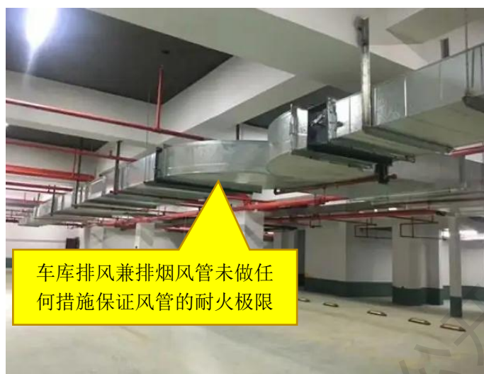
图 2.7.5-2 车库排烟风管无防火保护措施示意图
