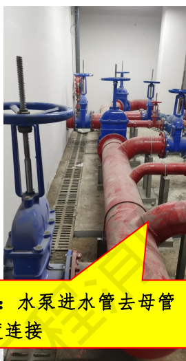
图 2.1.7 消防水泵吸水管安装示意图
