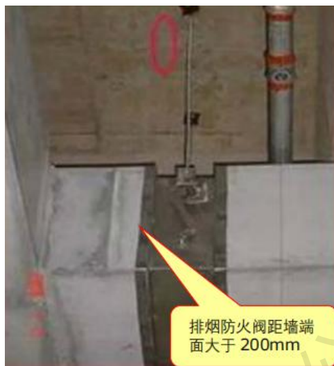
图 2.7.1-3 排烟防火阀安装排烟防火阀距墙端面大于 200mm
