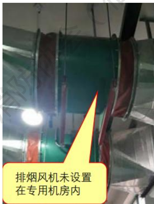
图 2.7.8-2 排烟风机未设置在风机房内
