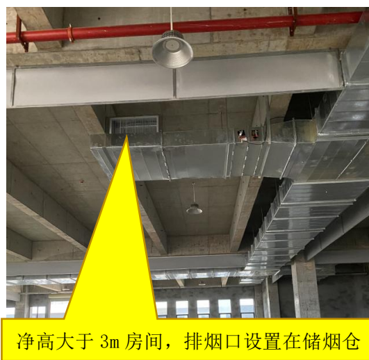
图 2.7.18-1 排烟口中已设置在储烟仓示意图
