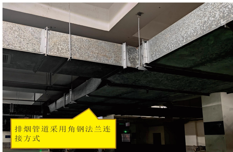
图 2.7.9-2 角钢法兰连接示意图
